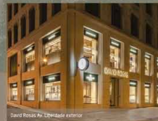
David Rosas Av. Liberdade exterior
